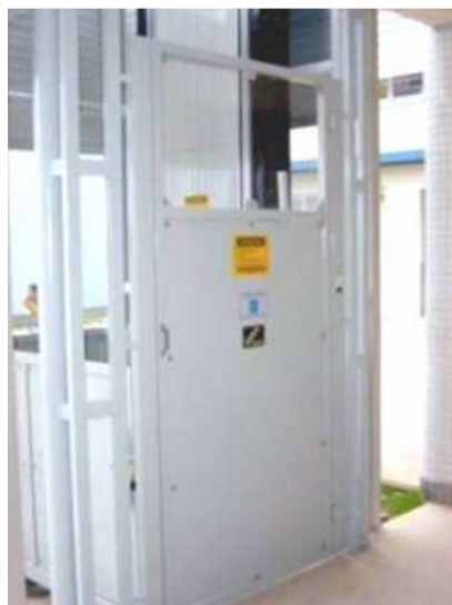
Figura 2-10 Elevador com mecanismo de lock-out. Fonte: http://www.dwa.eng.br/elevadores.html
